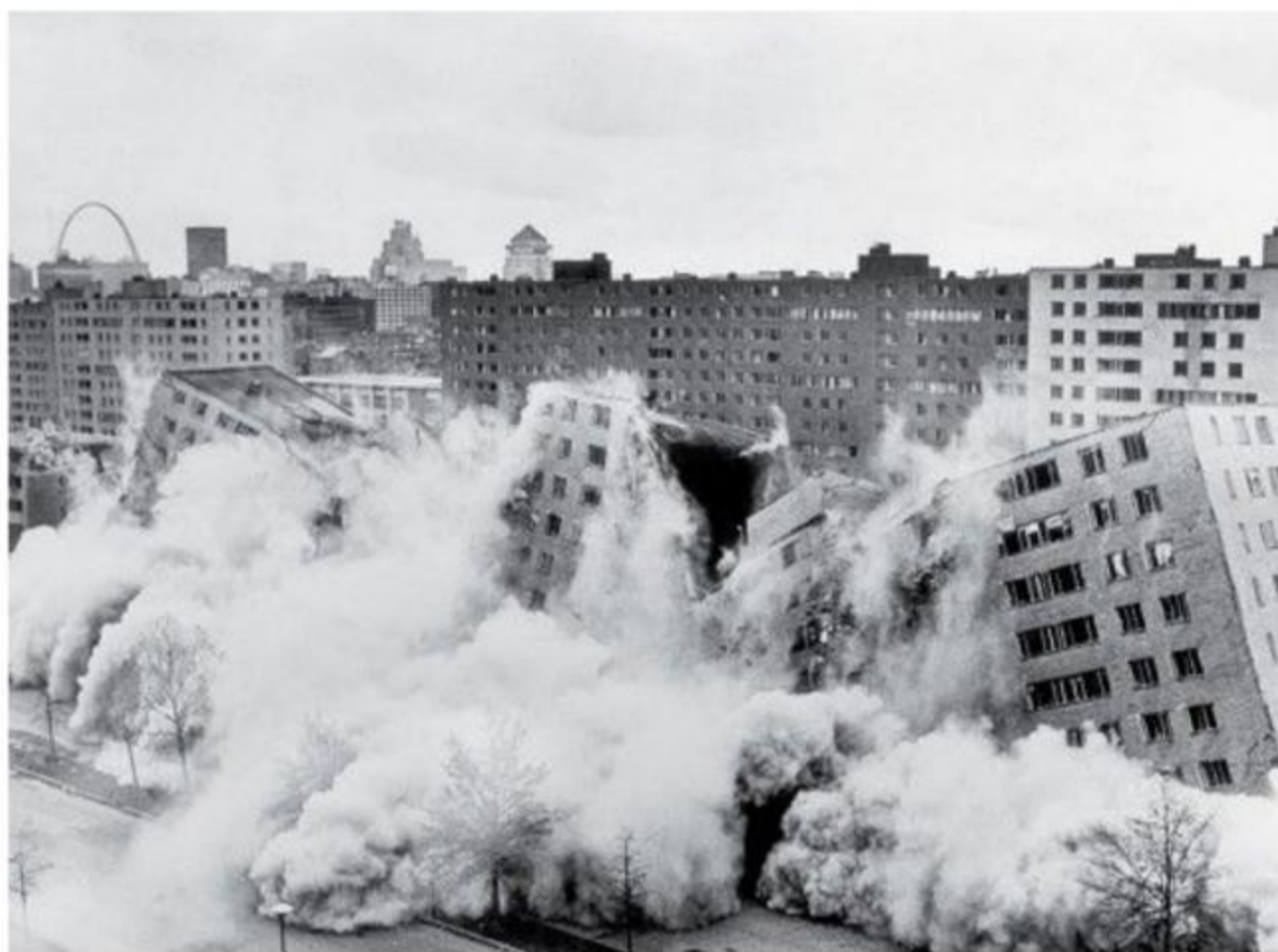
Demolição do conjunto habitacional de Pruitt-Igoe, Saint-Louis, 1972.
